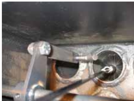
5. Sota konvektionsrörens yta med en borste, avlägsna flygaskan. Kör borsten ända ned och upp igen.
