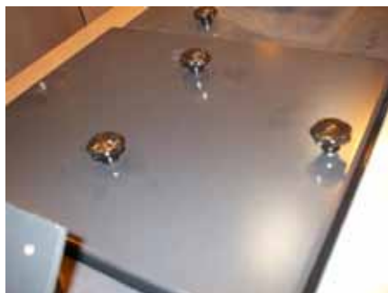
8. Sätt tillbaka sotluckan och skruva in stjärnvreden.
