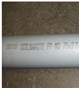
2. Tag fram ett 75 mm plaströr,
