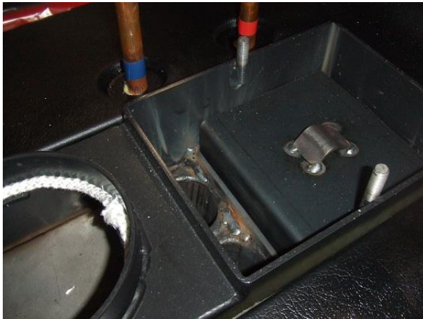
Under locket på toppen av pannan kommer man åt tuberna vid ekonomisotningen
