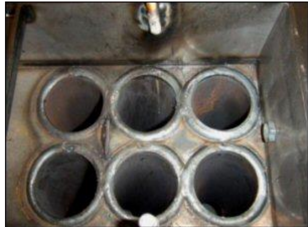
Tuberna syns här på bilden utan rökgasbromsen som man kan se på bilden till vänster.
